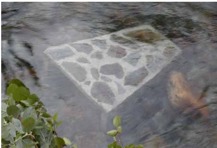
Cache en béton avec placage en pierre
